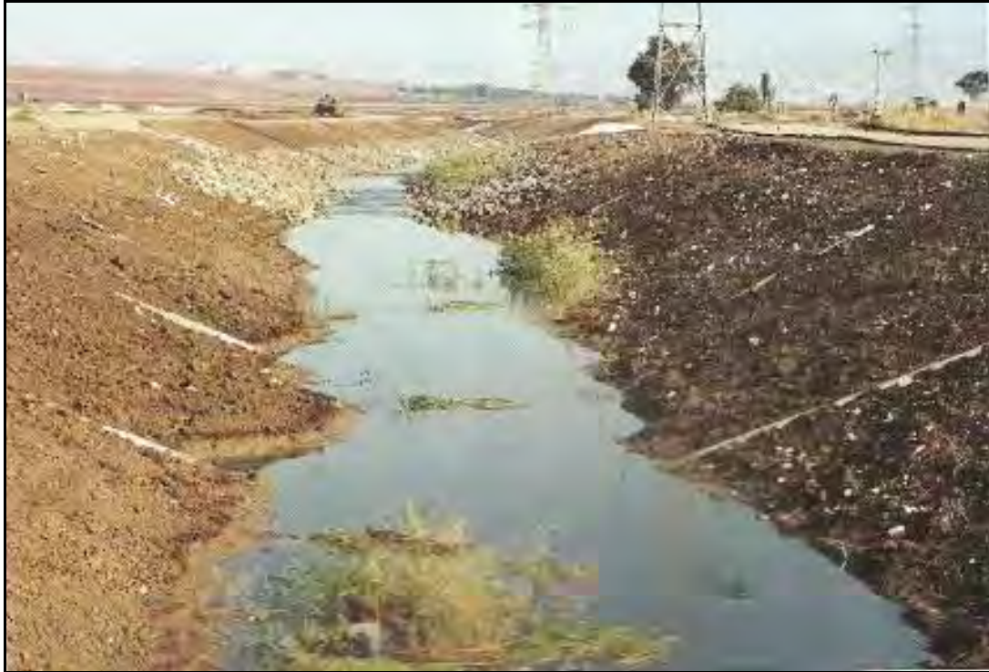
תמונה 3: מפתני בטון וביצורי אבן לייצוב גדות – נחל חרוד (מתוך תה"ל, 2000).
